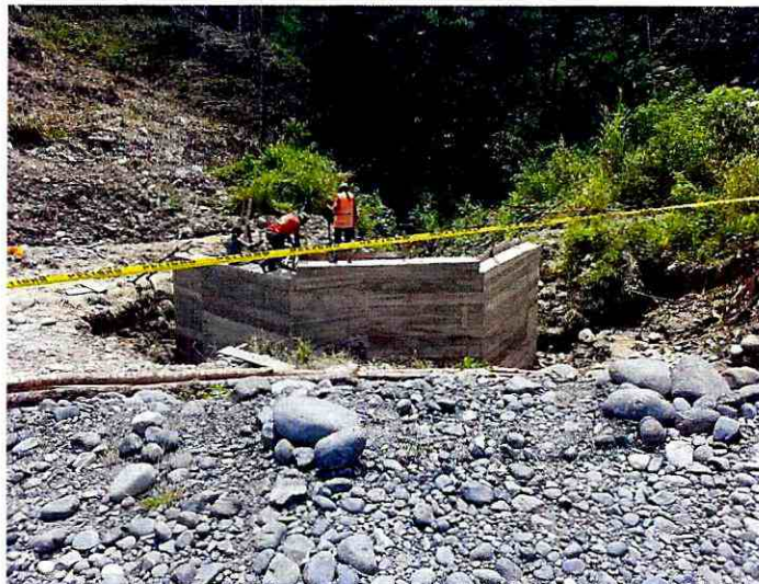
ANEXO 7. CONSTRUCCION DE CABEZALES ABSCISA 5+200.
