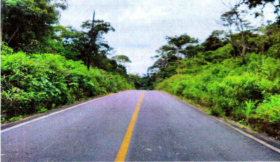
ASFALTADO A LA PARROQUIA CANELOS
