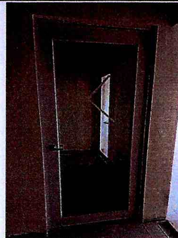
Puerta batiente aluminio y vidrio flotado claro 6mm (1.00x2.10)
