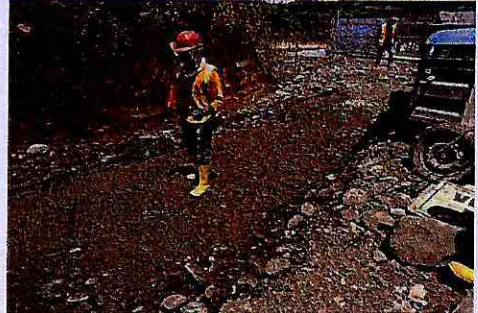
RELLENO COMpACTADO A mAQUINA CON LASTRE TNm=8" (EN CAPAS DE 20 Cm)
