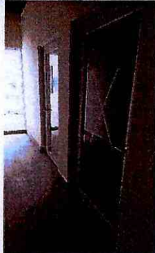
Puerta batiente aluminio y vidrio flotado claro 6mm (1.00x2.10)
