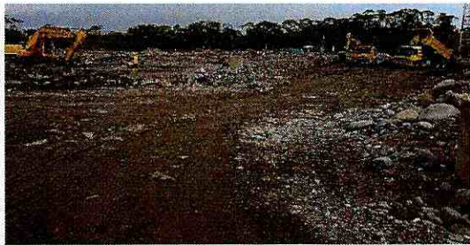
TRANSPORTE mATERIAL PETREODE mEJORAmIENTO
