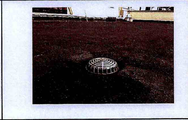
SUMIDERO DE CUBIERTA DE 110MM INCLUYE REJILLA TIPO CÚPULA
