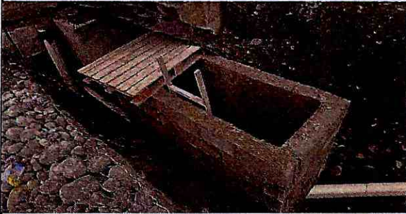
mAmPOSTERIA BLOQUE PESADO VIBRADO 4mPAE=15 Cm
