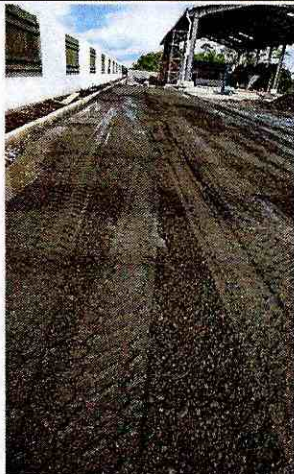
mATERIAL DE BASE GRANULAR DE AGREGADOS
