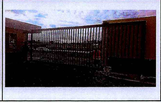
CERRAMIENTO VERJA DE TuBO HG 2" Y TuBO RECT 80X40X2, INC. PINTURA ComPRESOR
