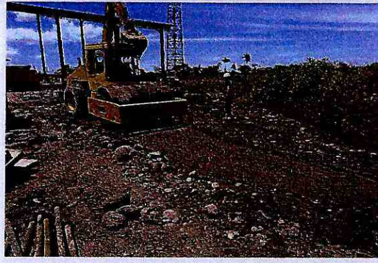
RELLENO COMpACTADO A mAQUINA CON LASTRE TNm=8" (EN CAPAS DE 20 Cm)
