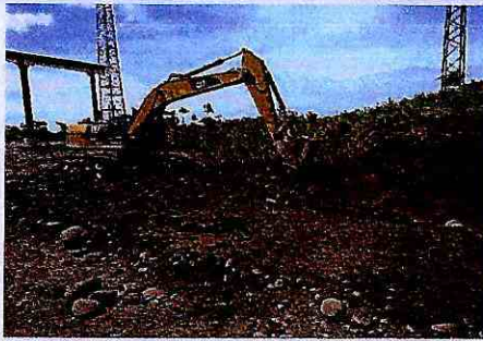
RELLENO COMpACTADO A mAQUINA CON LASTRE TNm=8" (EN CAPAS DE 20 Cm)
