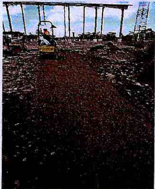
RELLENO COMpACTADO A mAQUINA CON LASTRE TNm=8" (EN CAPAS DE 20 Cm)
