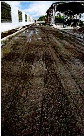
TRANSPORTE DE MATERIAL DE BASE GRANULAR DE AGREGADOS
