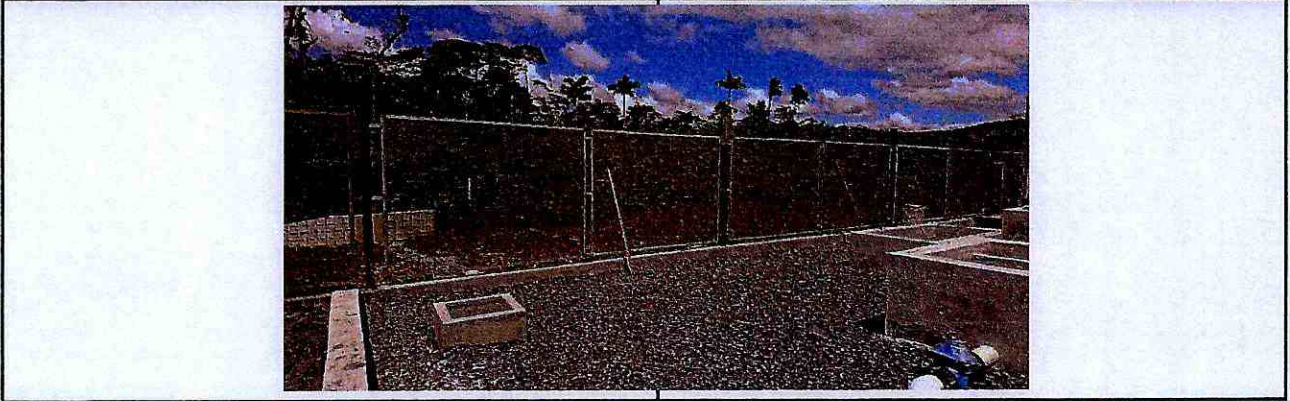
CERRAMIENTO TuBO H.G. 2 "-mALLA ELECTROSOLDADA 10X10X6mm, INC. PINTuRA A COmPRESOR
