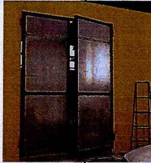
PuERTA mETÁLICA PANELADA TOOL GALV. 2mm , INC. CERRADuRA, BISAGRAS Y PINTuRA
