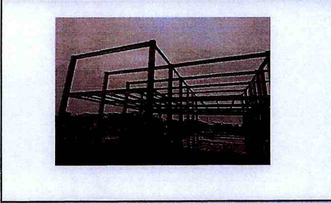
TRATAMIENTO PINTURA ESTRUCTURA ACERO A36 (FONDO+PINTURA ANTICORROSIVA), A COMPRESOR
