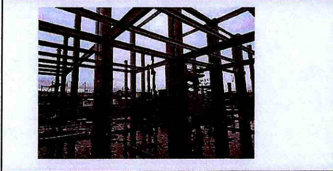
TRATAMIENTO PINTURA ESTRUCTURA ACERO A36 (FONDO+PINTURA ANTICORROSIVA), A COMPRESOR
