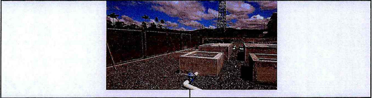
CERRAMIENTO TuBO H.G. 2 "-mALLA ELECTROSOLDADA 10X10X6mm, INC. PINTuRA A COmPRESOR
