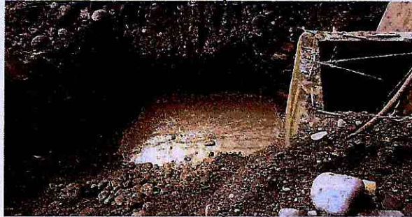
HORMIGON PREmEZCLADO REPLANTILLO F'C=180 KG/Cm2 INC. BOMBEO Y TRANSPORTE
