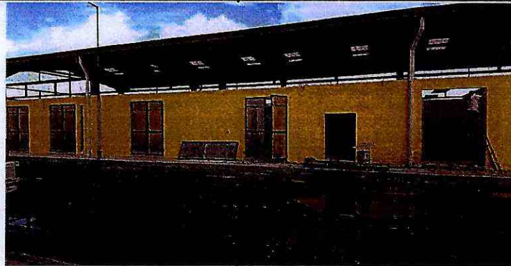
PuERTA mETÁLICA PANELADA TOOL GALV. 2mm , INC. CERRADuRA, BISAGRAS Y PINTuRA
