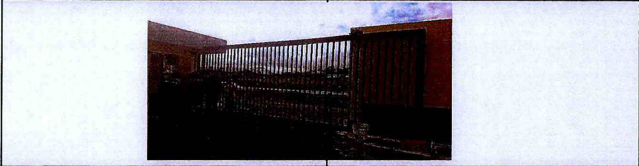
CERRAMIENTO VERJA DE TuBO HG 2" Y TuBO RECT 80X40X2, INC. PINTURA ComPRESOR
