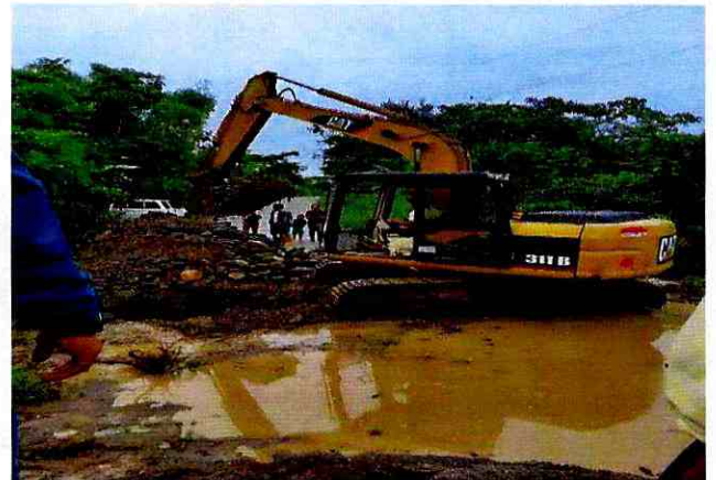
ANEXO 9 EXCAVACIÓN A MÁQUINA EN CONGLOMERADO
