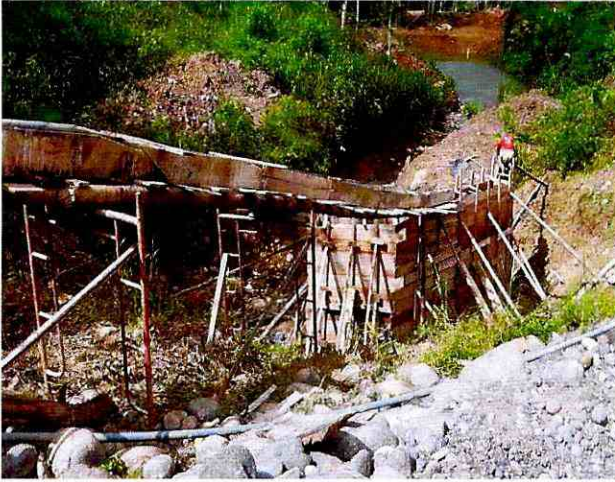
ANEXO 7. CONSTRUCCION DE MURO DE H.S. F TIPO B (CABEZALES)
