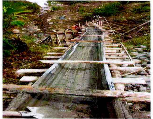
ANEXO 7. CONSTRUCCION DE MURO DE H.S. F TIPO B (CABEZALES)
