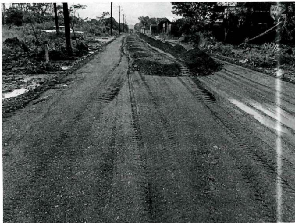
Fotografía N°01: Colocacion de Base Clase II
