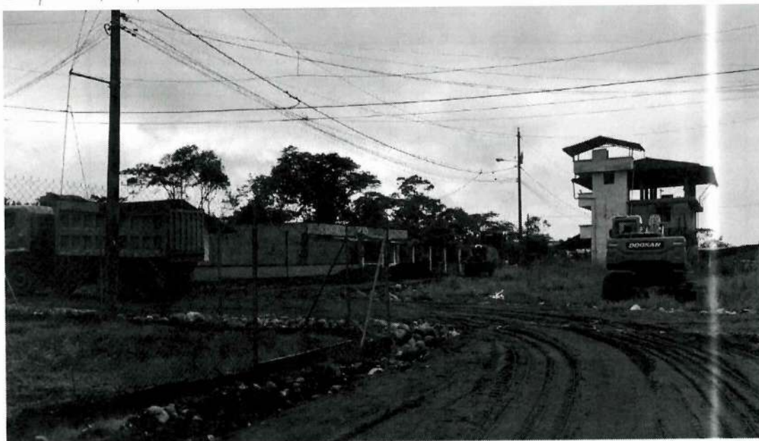
Fotografía N°03: Colocacion de Base Clase II
