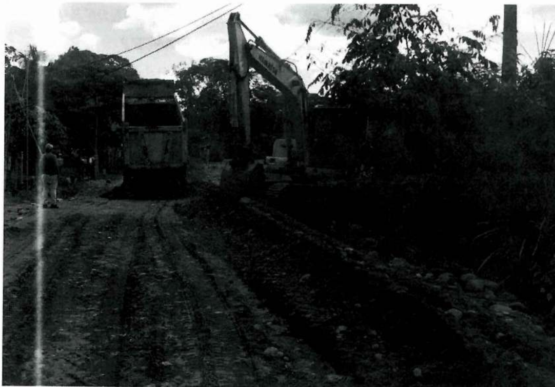
Fotografía N°01: Colocacion de Base Clase II
