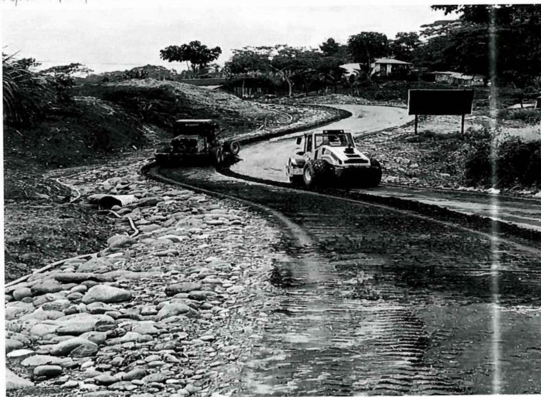
Fotografía N°02: Colocacion de Base Clase II
