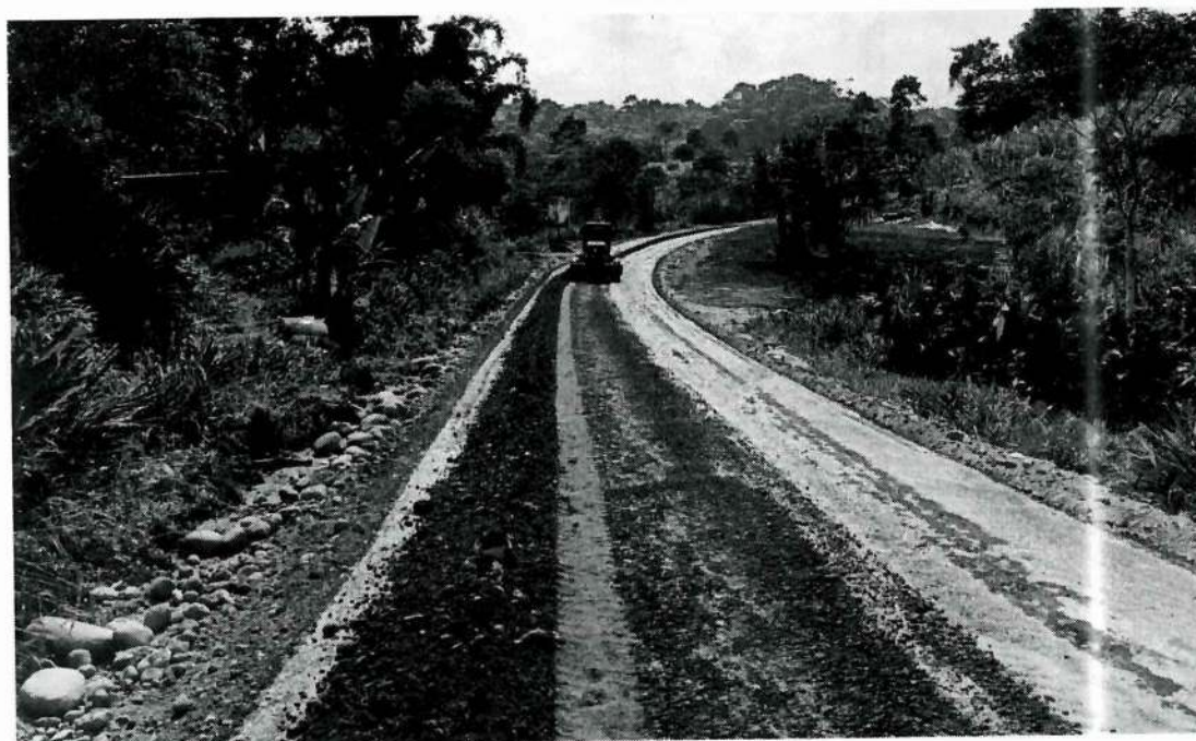
Fotografía N°03: Colocacion de Base Clase II
