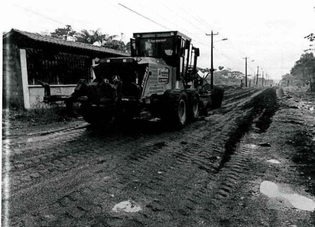
Fotografía N°02: Colocacion de Base Clase II
