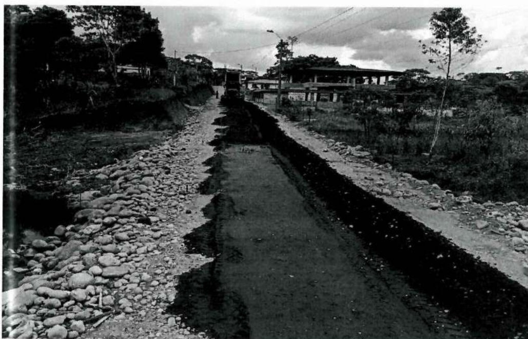
Fotografía N°03: Colocacion de Base Clase II
