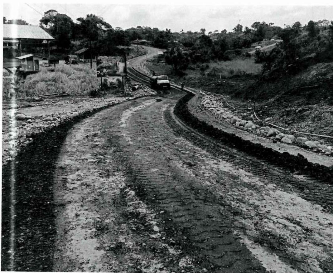
Fotografía N°01: Colocacion de Base Clase II
