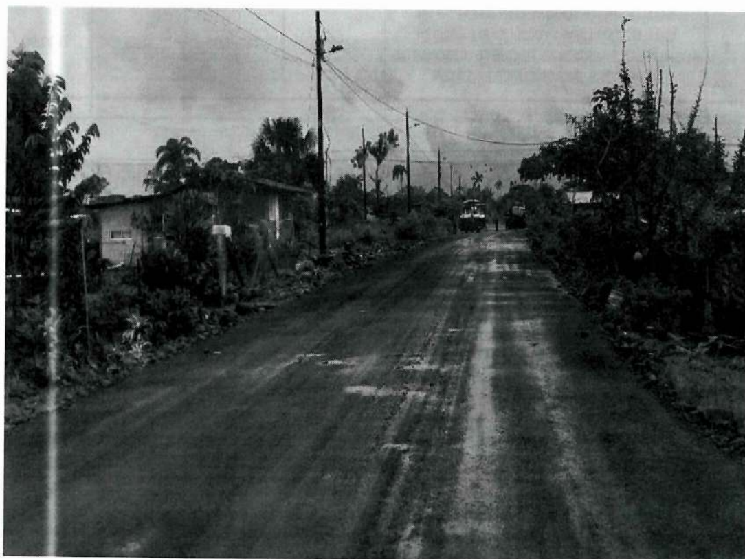
Fotografía N°02: Colocacion de Base Clase II
