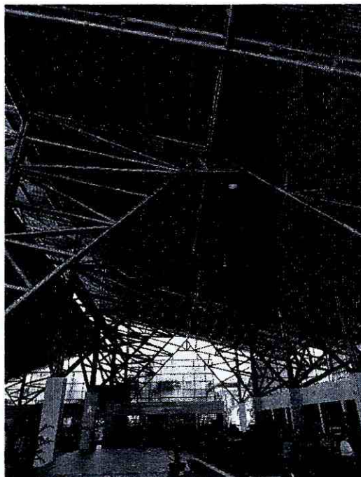
Fotografía 2, Análisis de estructura con material de guadua
