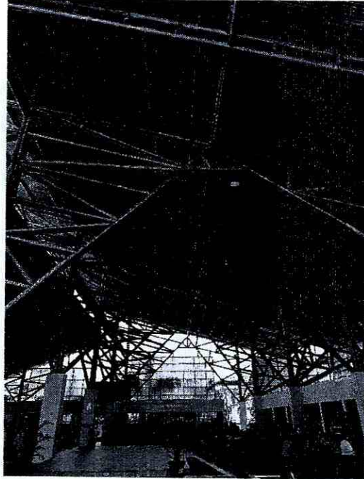
Fotografía 2, Análisis de estructura con material de guadua
