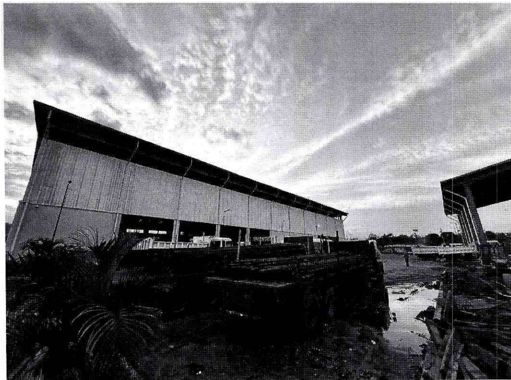
Fotografía 4, Ingreso de Tracto camino a los hangares del GADPPz.
