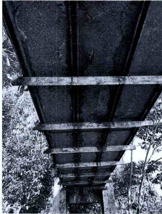
Ilustración 10, estructura del tablero metálico del puente colgante
