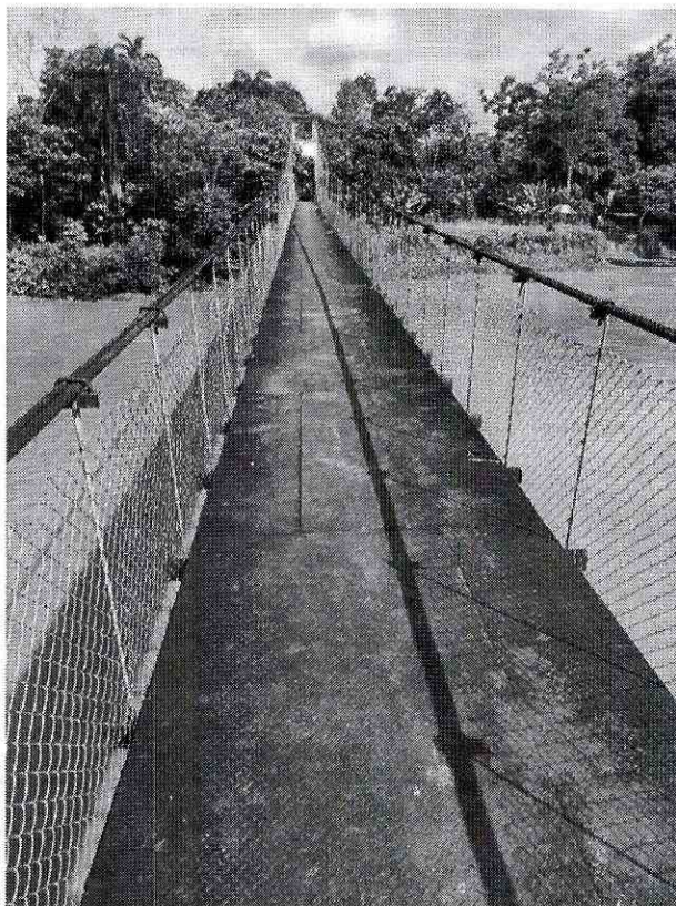
Ilustración 8, Estructura del puente
