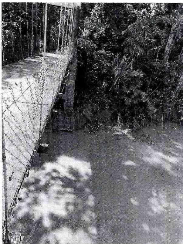
Ilustración 5, Margen derecho del puente sobre el río curaray 18 de marzo 2025
