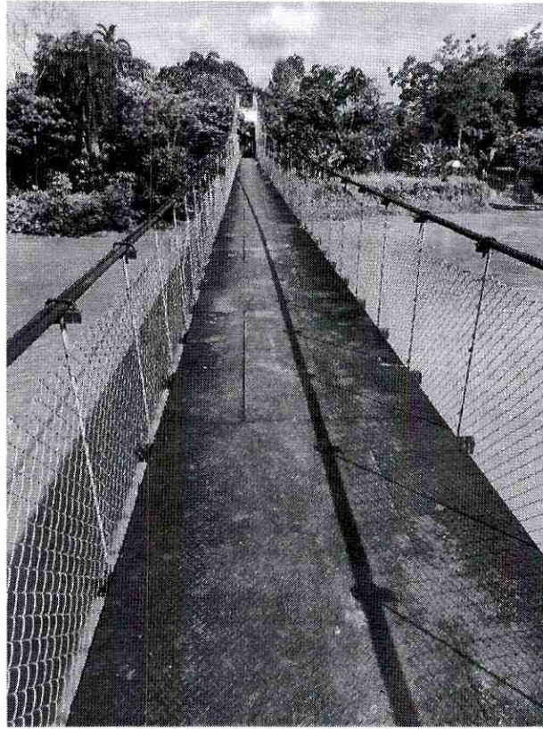
Ilustración 8, Estructura del puente
