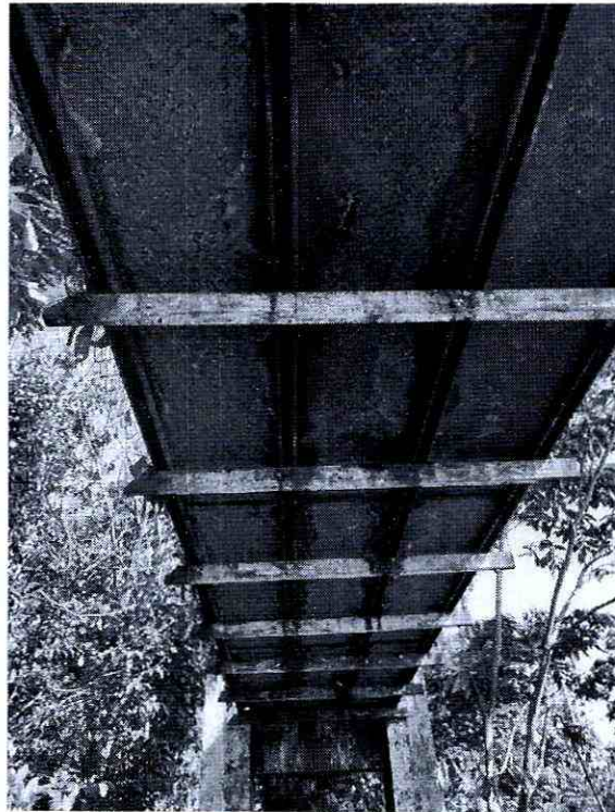
Ilustración 10, estructura del tablero metálico del puente colgante
