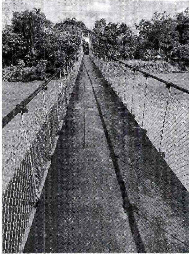
Ilustración 8, Estructura del puente
