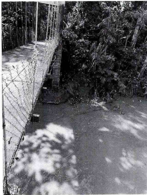
Ilustración 5, Margen derecho del puente sobre el rio curaray 18 de marzo 2025
