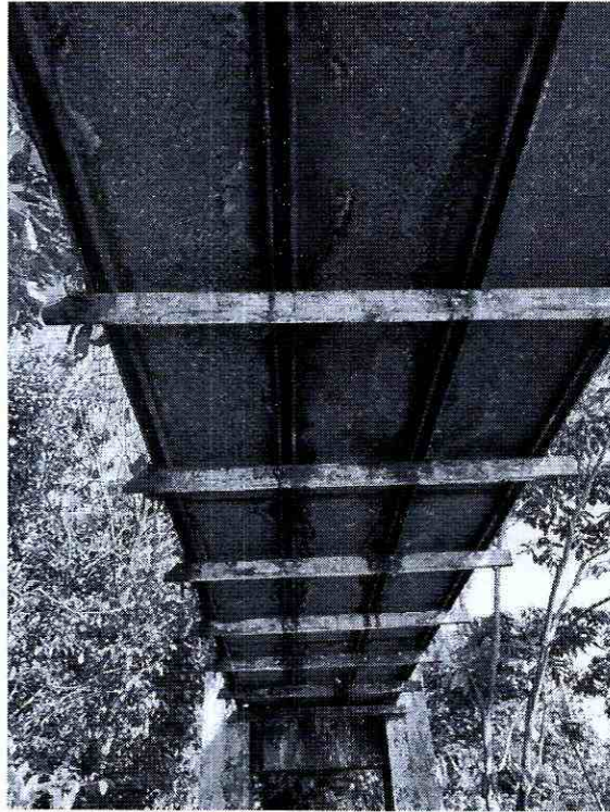
Ilustración 10, estructura del tablero metálico del puente colgante
