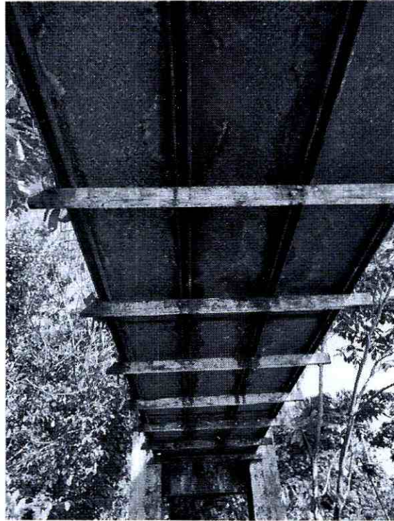
Ilustración 10, estructura del tablero metálico del puente colgante
