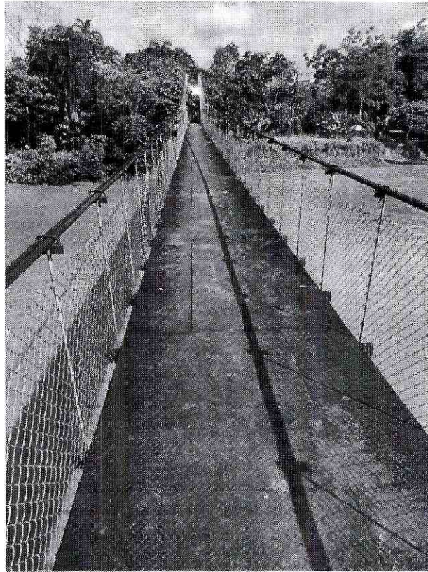
Ilustración 8, Estructura del puente
