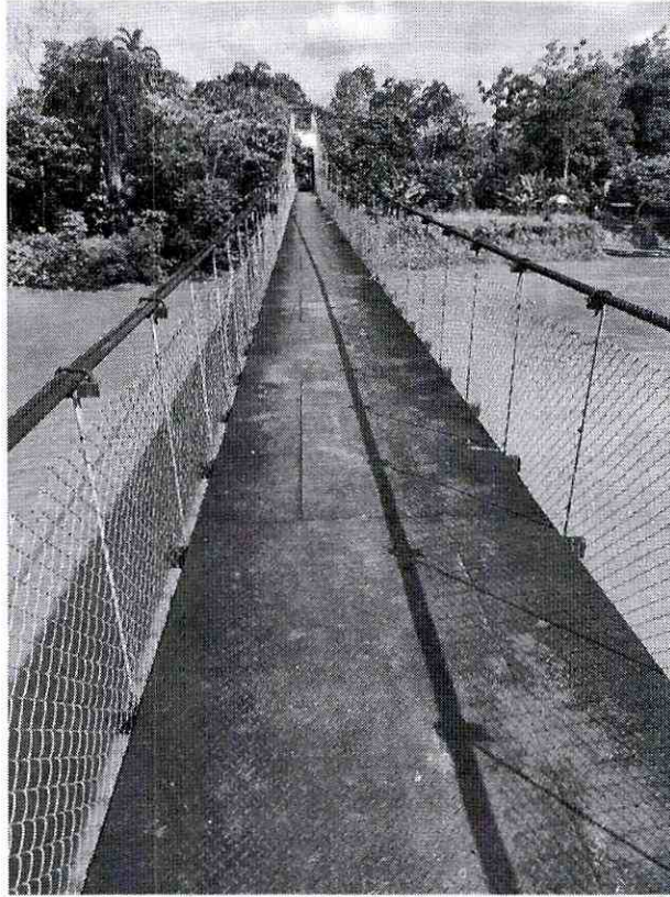
Ilustración 8, Estructura del puente
