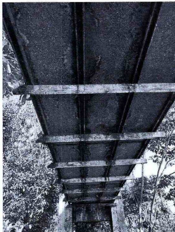
Ilustración 10, estructura del tablero metálico del puente colgante
