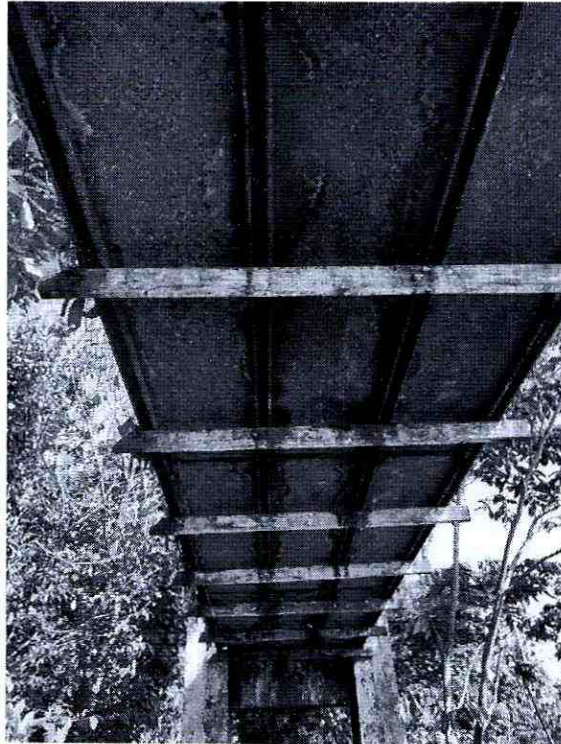
Ilustración 10, estructura del tablero metálico del puente colgante
